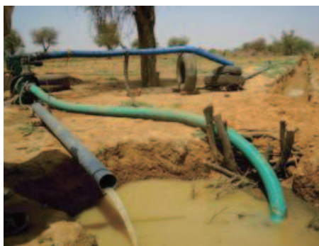
写真Ⅱ.2.17 動力ポンプによる揚水(2011年3月)
