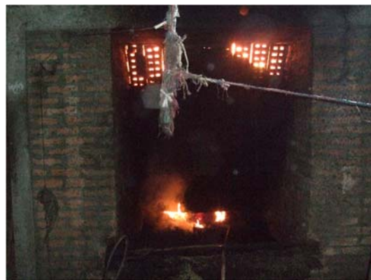
粳殻燃料のボイラー釜炊き口
