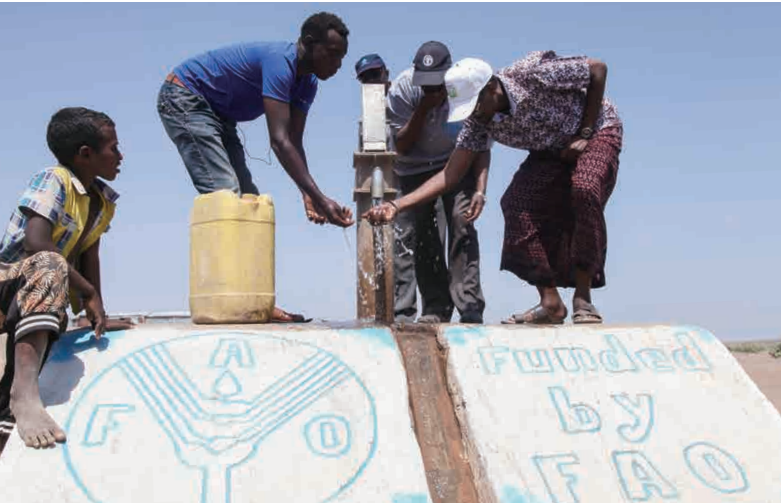
上：この地域で伝統的に利用されている水蒸気井戸（Steam well）。地中の火山岩から噴き出す蒸気の周りを岩で囲み、冷却した水をcollectしている。下：FAOの支援で改良された水蒸気井戸。より安定的な水供給が可能となった。
