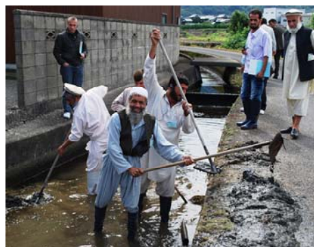
▲水路の堆砂排除を実施
