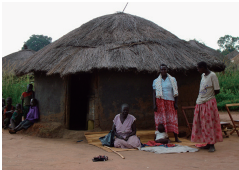
昔ながらの農村の家。土の壁と植物の葉の屋根で作られている。中は薄暗いがひんやりと涼しい。
