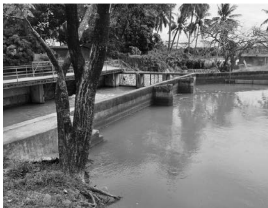
写真1 サイホン式水路（左：上流部の貯水池、右：サイホンからの流出部）
