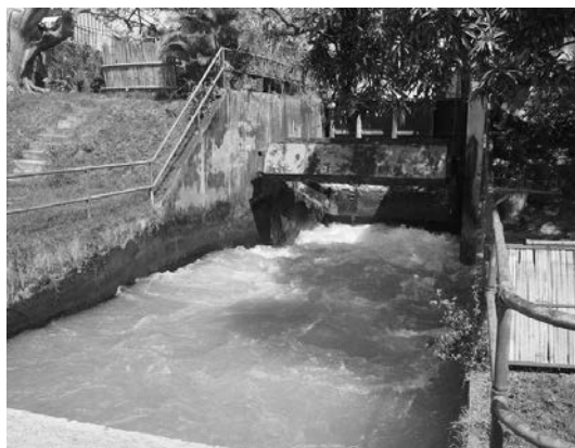
写真1 サイホン式水路（左：上流部の貯水池、右：サイホンからの流出部）
