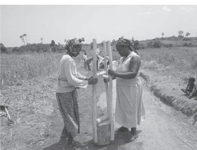
⑧ 覆被土もしっかり締固め、補修工事終了
