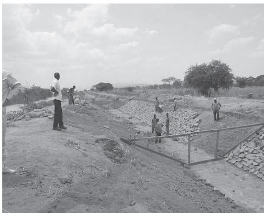
写真 II.1.95 積立金で水路ライニング工事
