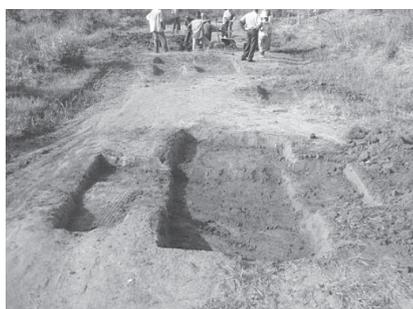
③ 土のうが所定の大きさになるまで締固められるように穴の大きさを整形する
