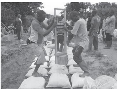
⑥ 土のうをタコで叩き、固くなるまで締固める
