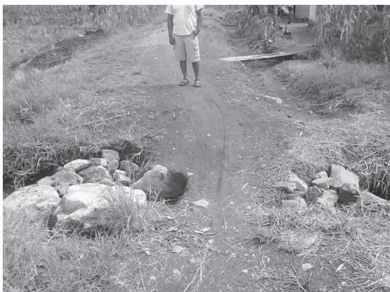
1. 施工前：カルバートが破損し、石で代用するも幅員が狭く車両通行不可
