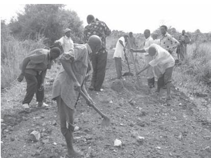
⑦ 締固めた土のうの上に土を被せる
