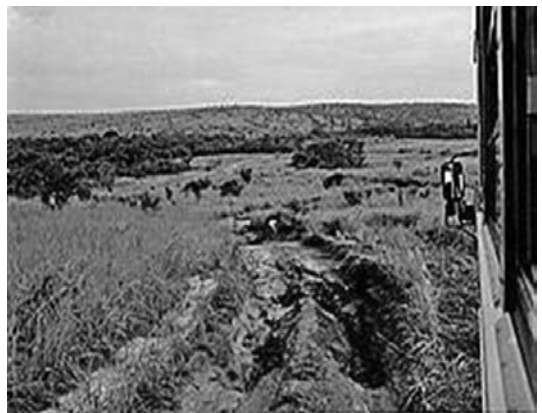
写真２ 侵食によって悪路と化した道
