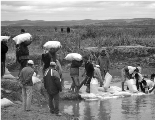
写真1 サハベ川堰破損箇所の補修
