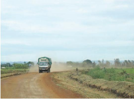
写真 19 ムエア灌漑スキーム内の未舗装農道。輸送トラックも利用するが、雨の日は路面が簡単に悪くなり、スタックし易い。
