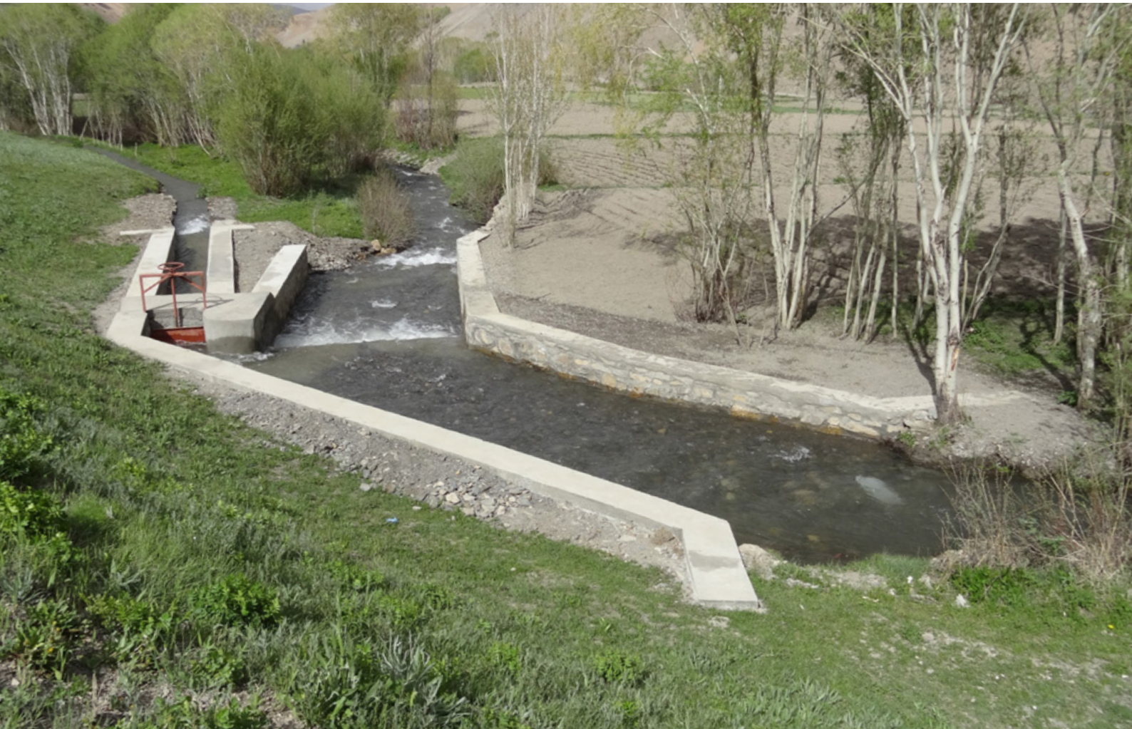
上：完成後の水路（バークマン県）。325haの灌漑面積を有し、約470世帯の農家が恩恵を受けている。下：修復を終えた水路の取水工（バークマン県）。プロジェクトは昨年9月に第4フェーズを迎え、今後、1万6,000世帯の農家が受益する28の灌漑施設の復旧や農家向けの研修などが予定されている。
