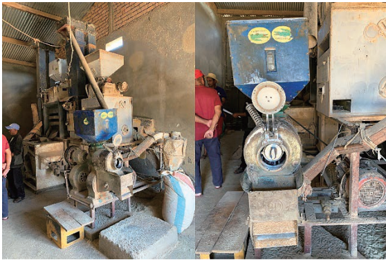
写真3 粳摺り機（奥）と精米機（手前）の2工程
