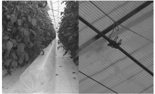
写真3 ヒートポンプ（左）と細霧冷房（右）
