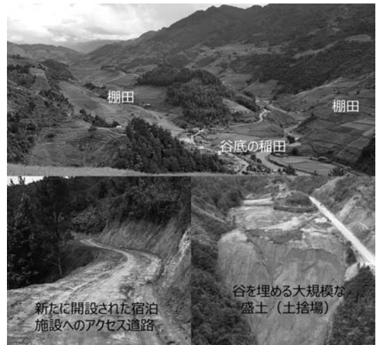
図2 (上) イエンバイ省ムーカンチャイ谷(キムノイ川谷)の景観。(下左) 斜面を掘削して建設された道路、および(下右) 大規模な盛土
