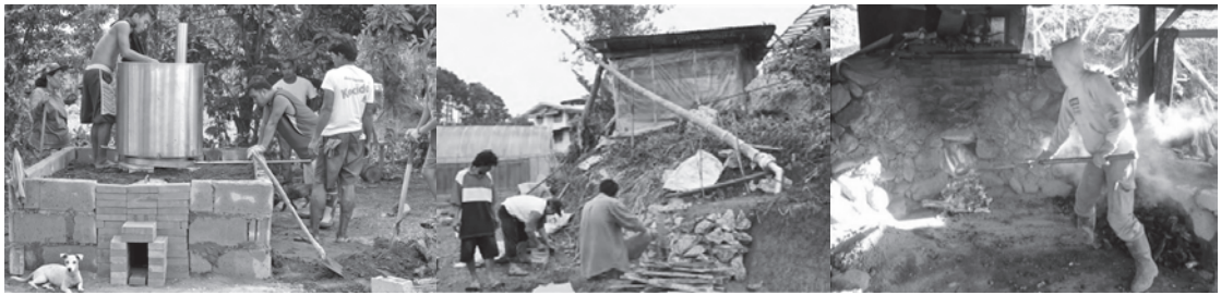
写真 フィリピンで建設された木酢施設（左から水冷式ドラム缶型施設、空冷式ドラム缶型施設、木酢施設を岩で囲ったもの）
