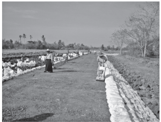
写真2 輪中堤防の人力
