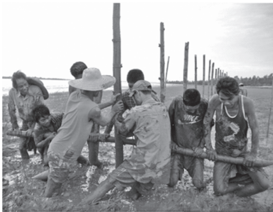
写真4 マングローブ補植のためのフェンス立て
