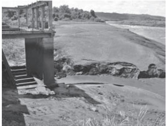
写真3 Nkula 発電所取水堰の土砂堆積
