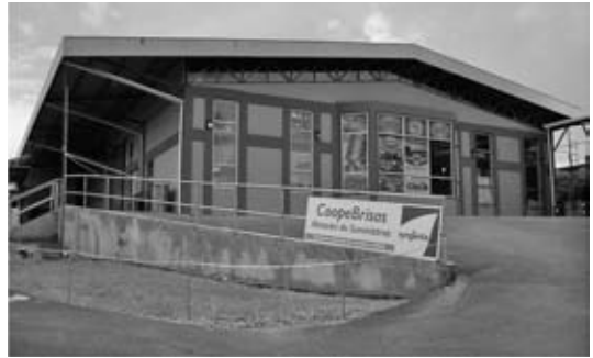
写真2 資機材販売店外景
