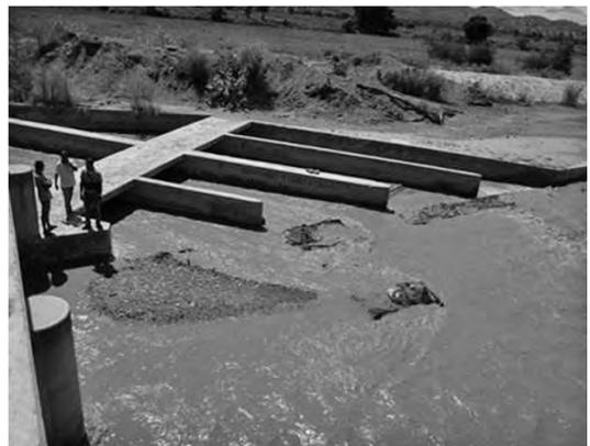
写真 1 取水口の前に堆積する土砂
