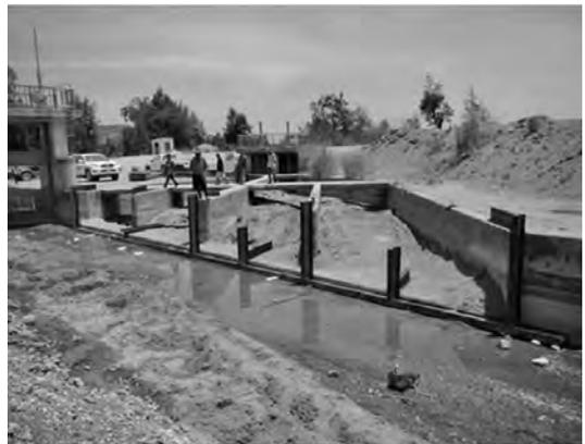
写真3 取水口の前に角落し設置
